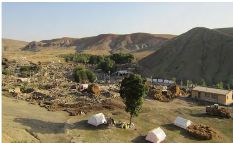
شکل ۷. عملکرد مناسب و بدون آسیب ساختمان مدرسه در زلزله ۲۱ مردادماه ۱۳۹۱ (۱۱ آگوست ۲۰۱۲)
