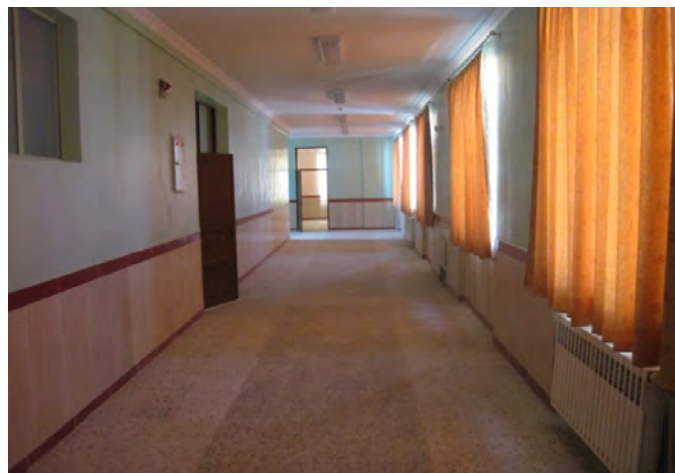
شکل ۸. عملکرد مناسب و بدون آسیب ساختمان مدرسه مقاوم سازی شده در زلزله ۲۱ مردادماه ۱۳۹۱ (۱۱ آگوست ۲۰۱۲ میلادی) آذربایجان شرقی (اهر - ورزقان) ( بزرگای زلزله ۶/۴ ریشتر در عمق ۹/۵ کیلومتری از سطح زمین)
