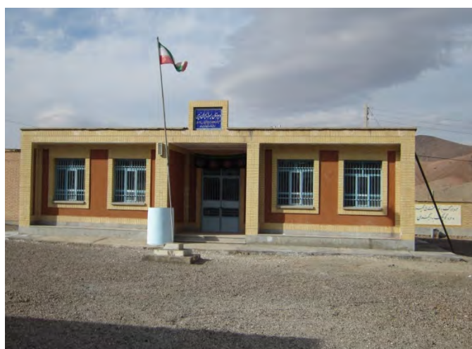
شکل ۱۰. عملکرد مناسب و بدون آسیب ساختمان مدرسه مقاوم سازی شده در زلزله سال ۱۳۹۰ خراسان جنوبی
