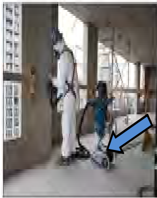
تصویر شماره 53: دستگاه سایش سنگ مجهز به کانال و سیستم مکنده موضعی
